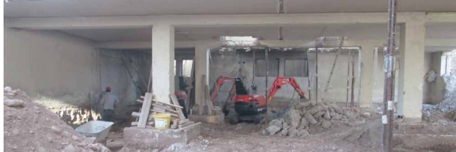
Blick in die Baustelle: Hier entsteht die Gesundheitswelt Kinzigtal.
